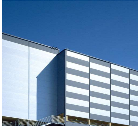
Rajah 7.0 – Penggunaan cladding jenis sandwich panel yang banyak dipasang di pusat data.
